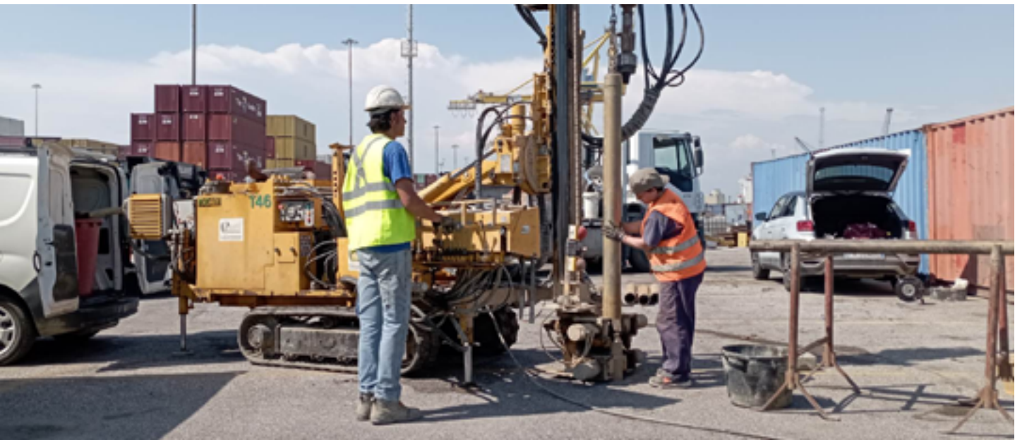
➤ Esecuzione dei sondaggi per la caratterizzazione ambientale delle aree a terra
