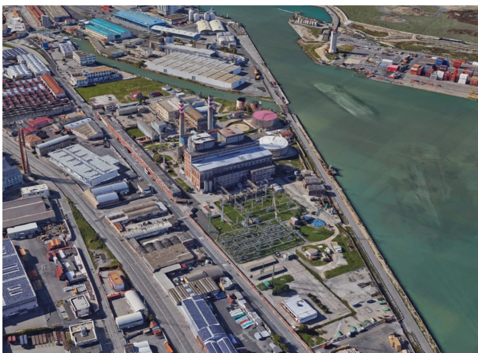
Figura 20 - Vista della Centrale Marzocco-Ex Enel
