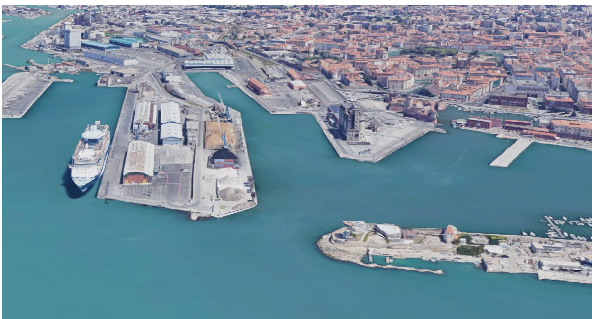
Figura 8 - Vista area di intervento
