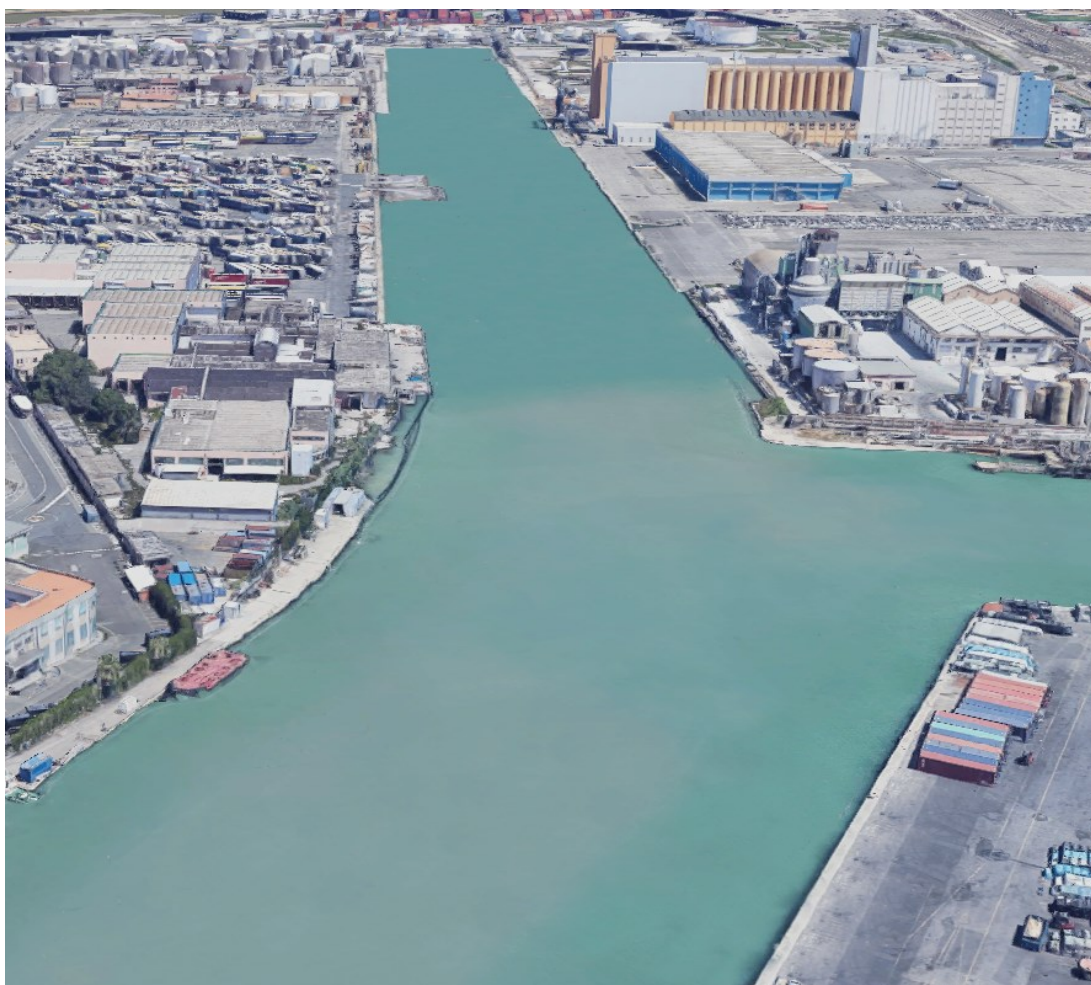
Figura 13 - Vista Canale Industriale
